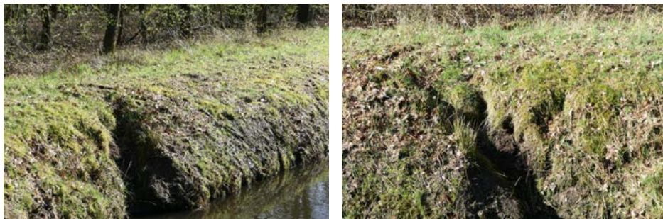
Abbildung 1: Starke Grabeaktivität durch Nagetiere im Damm eines Fischteichs, Fotos: © Thünen-Institut / Vincent Lugert.
