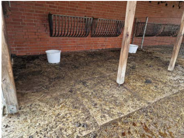
Abbildung 1: Planbefestigter Boden im Witterungsschutz mit verkotetem bzw. verschmutztem Untergrund (Score 1), Foto: © HU-Berlin / Marlen Bielicke.
