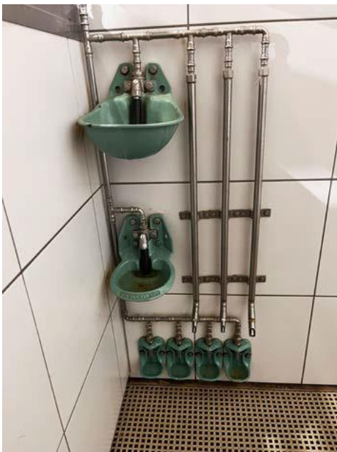
Abbildung 12: Tränken in einer Kontroll- und Sammelstelle, die für verschiedene Tierarten und Nutzungsrichtungen geeignet sind (Mast-/Zuchtrind, Kalb, Schaf, Ziege, Mast-/Zuchtschwein, Ferkel)
