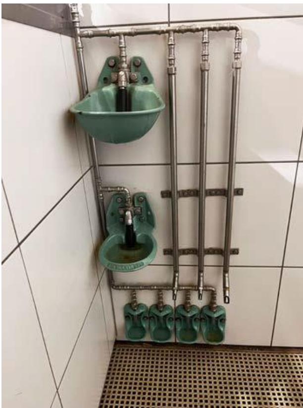
Abbildung 8: Tränken in einer Kontroll- und Sammelstelle, die für verschiedene Tierarten und Nutzungsrichtungen geeignet sind (Mast-/Zuchtrind, Kalb, Schaf, Ziege, Mast-/Zuchtschwein, Ferkel)
